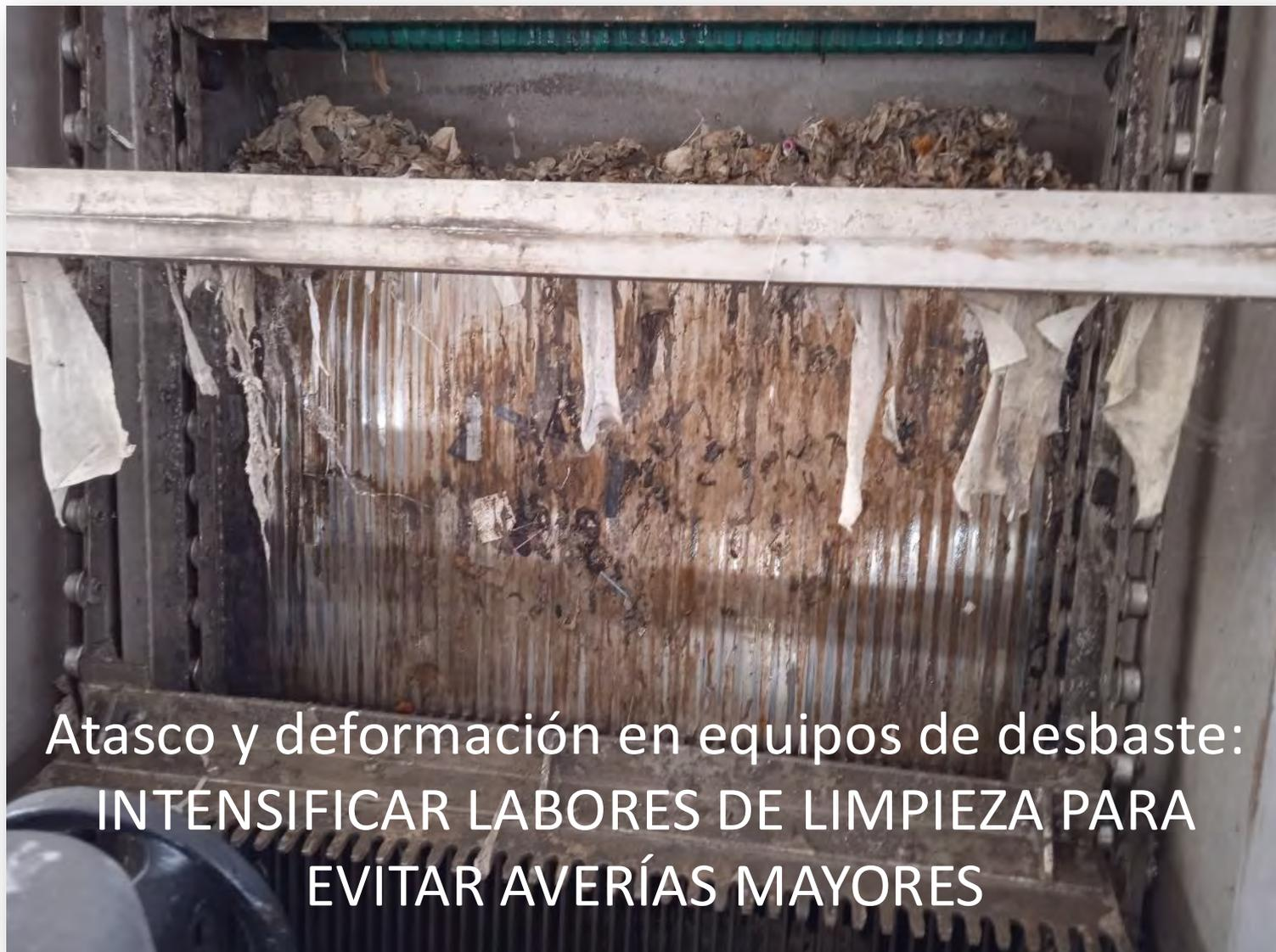
Atasco y deformación en equipos de desbaste:
