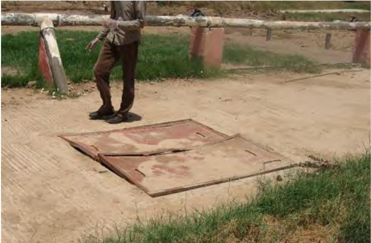
**Falta de conservación en elementos metálicos (tubería y tapa de arqueta)**
