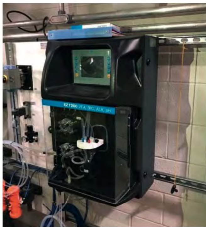
Vista del analizador EZ7250: medición en continuo y de una sola vez de AGV, alcalinidad, bicarbonato y pH
