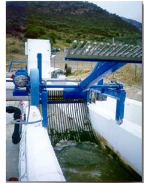
Reja curva de limpieza automática. (canales poco profundos: 0,4 – 2,0 m)
