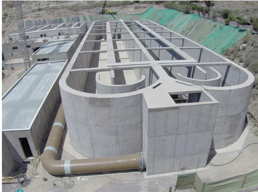
La duración del proceso depende del proceso buscado,- eliminación de DBO, eliminación de nutrientes, estabilización aeróbica-, y de la temperatura del agua.
