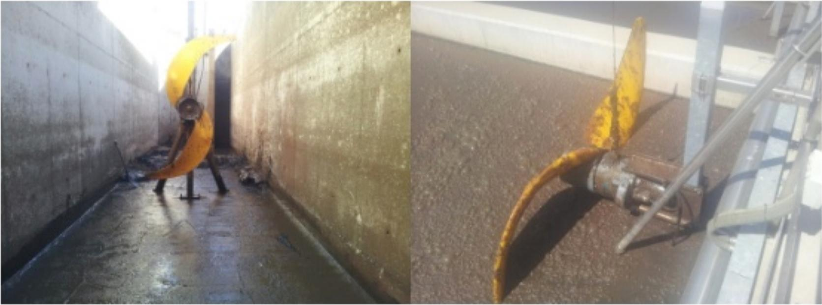
Un acelerador de corriente es también un dispositivo que transforma la energía eléctrica en energía mecánica. Su funcionamiento más usual es el de aumentar la energía a un fluido, en este caso al líquido contenido en los reactores biológicos de la EDAR/ PTAR o licor mixto en el caso de los reactores de carrousel o canales de oxidación, a fin de conseguir el estado de "mezcla completa" con el agua de entrada que fluye más o menos.
