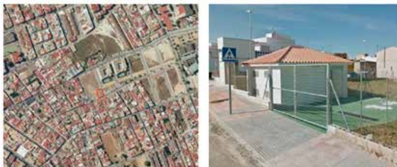
Figura 39. Grupo de presión Calle Alcalá.
